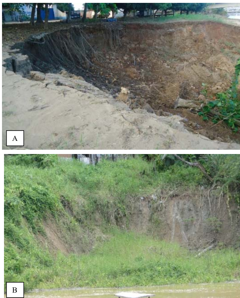
Figura 4.4 - Eventos ocorridos em fevereiro de 2015, logo após o rebaixamento do nível das águas no rio Acre: A) unidade QVA2; B) unidade SVM3.
