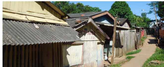
Detalhe das edificações presentes na célula 278
