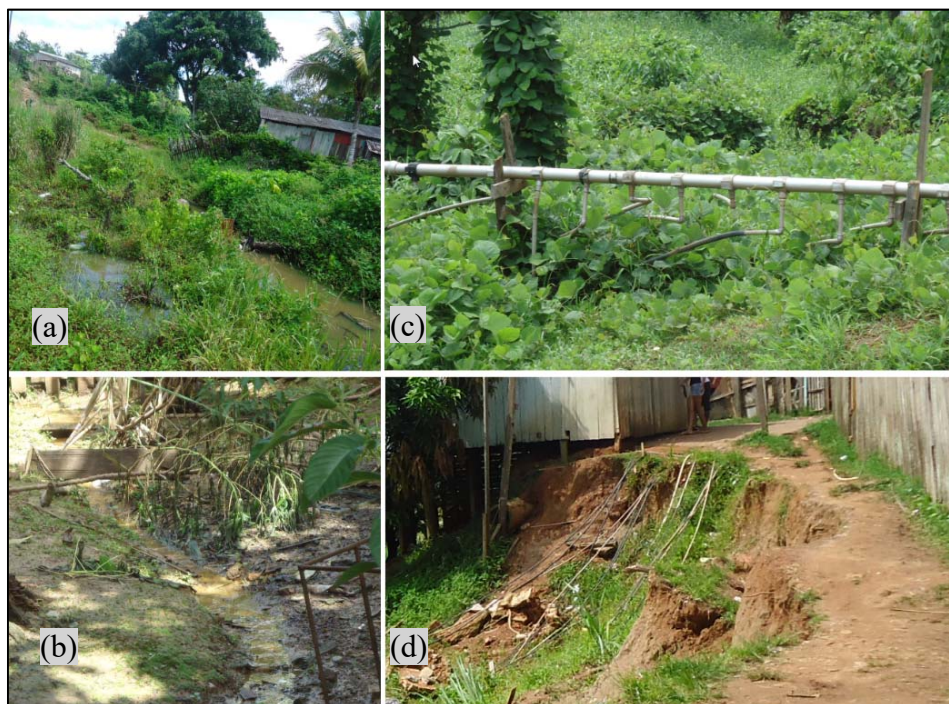
Figura 3.14 - Concentração de águas superficiais na área avaliada. a) concentração de água de chuva em área com rastejo. b) lançamento de águas servidas em área com rastejo. c) ligações clandestinas em área com rastejo. d) ligações clandestinas em área escarpada.
