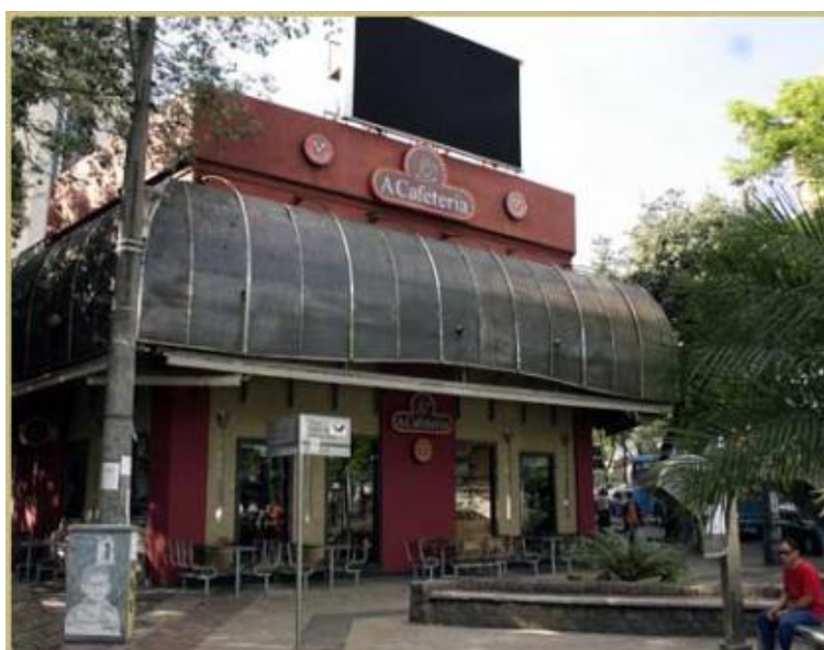
FIGURA 122: A Cafeteria antes da chegada da operadora Claro, com a fachada voltada para o cruzamento central da Pra a e o mobili rio fixo.
