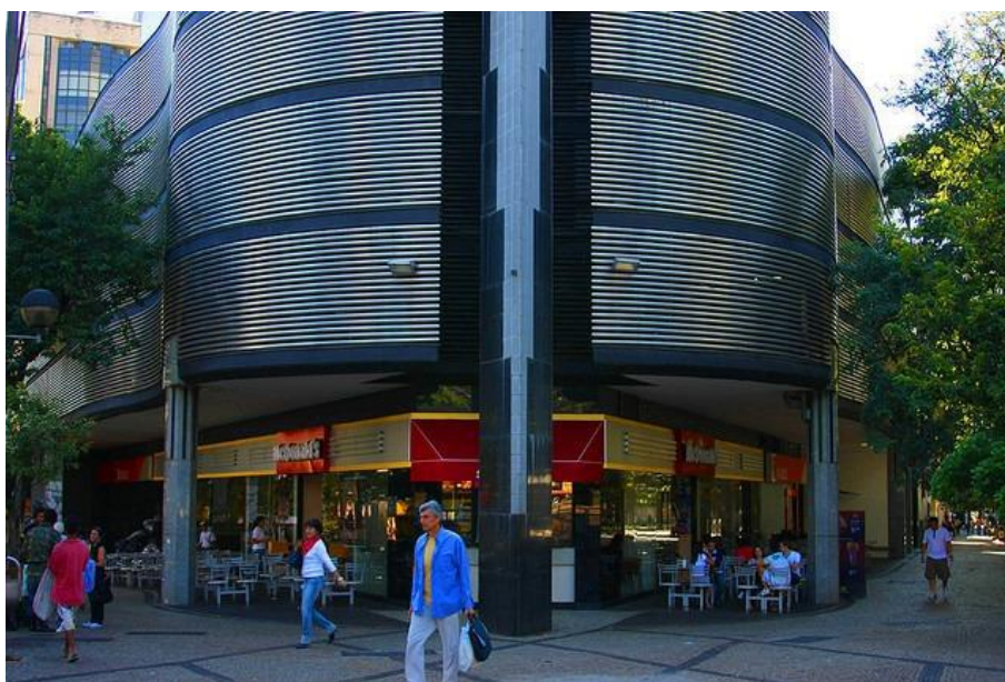
FIGURA 102: Fachada do McDonald's voltada para o centro da Praça da Savassi.
