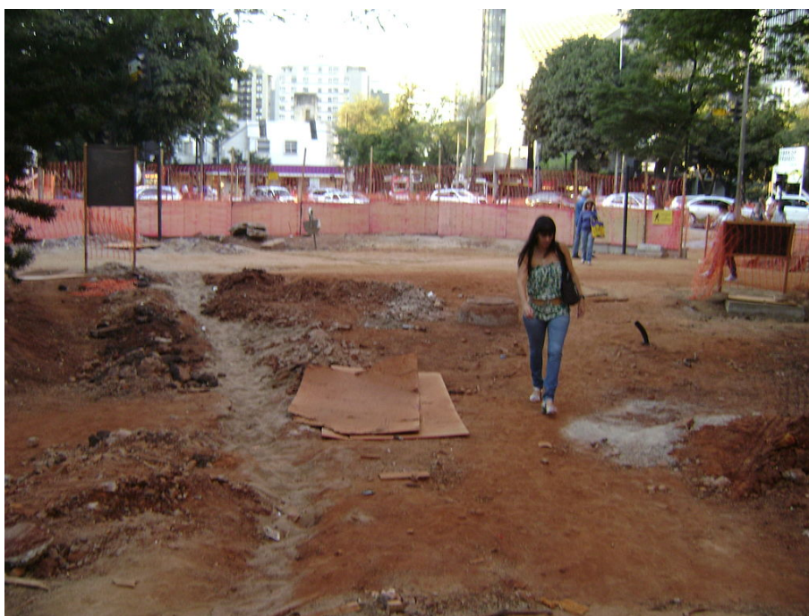
FIGURA 81: Trânsito de pedestres durante a obra.
