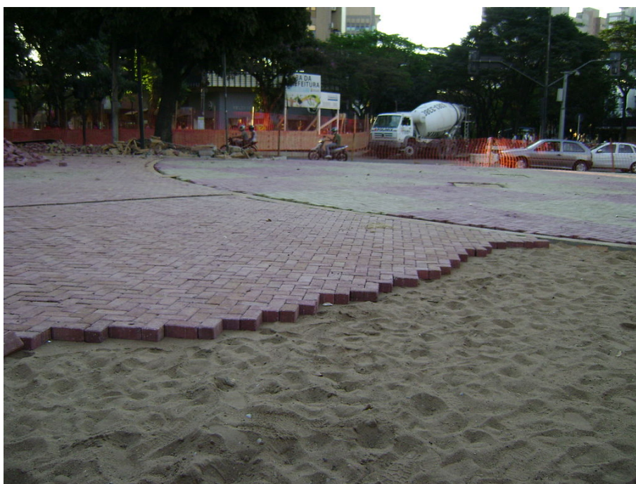
FIGURA 82: Detalhe da colocação do piso no cruzamento central.
