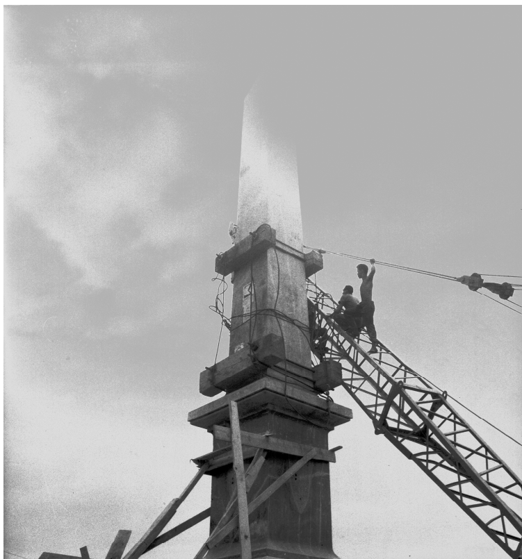
FIGURA 23: Instalação do obelisco na Praça da Savassi.
