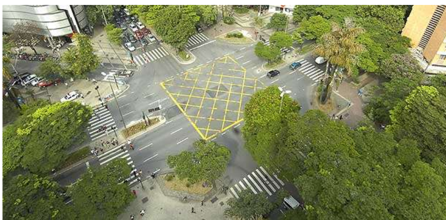
FIGURA 78: Praça da Savassi antes das obras.
