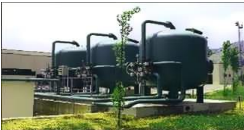
FIGURA 4.6: Colunas de fluxo contínuo.
