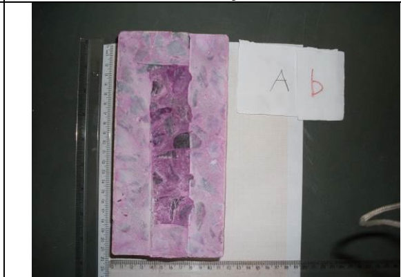
Ensaio de Carbonatação Amostra A b
