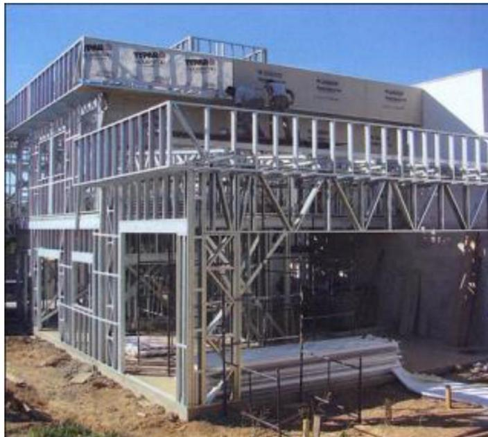
Figura 1.1 – Estrutura de uma residência em *Light Steel Framing* (CBCA, 2006)
