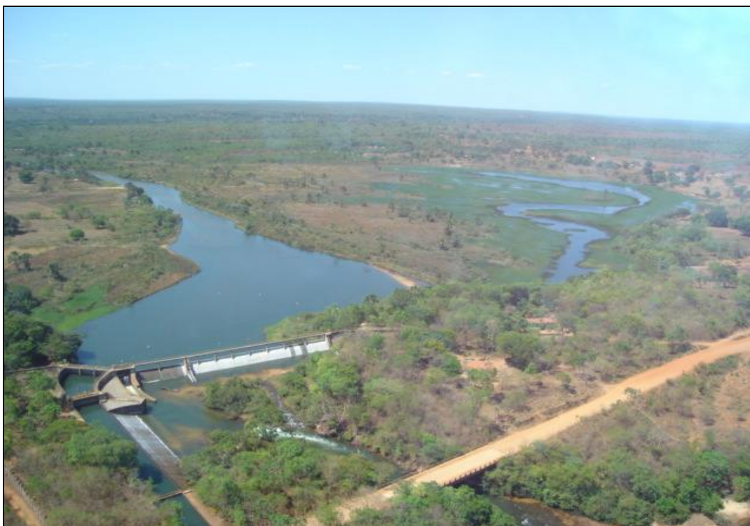
Figura 3.1 – Assoreamento do reservatório da PCH Pandeiros. Fonte: CERPCH/UNIFEI.
