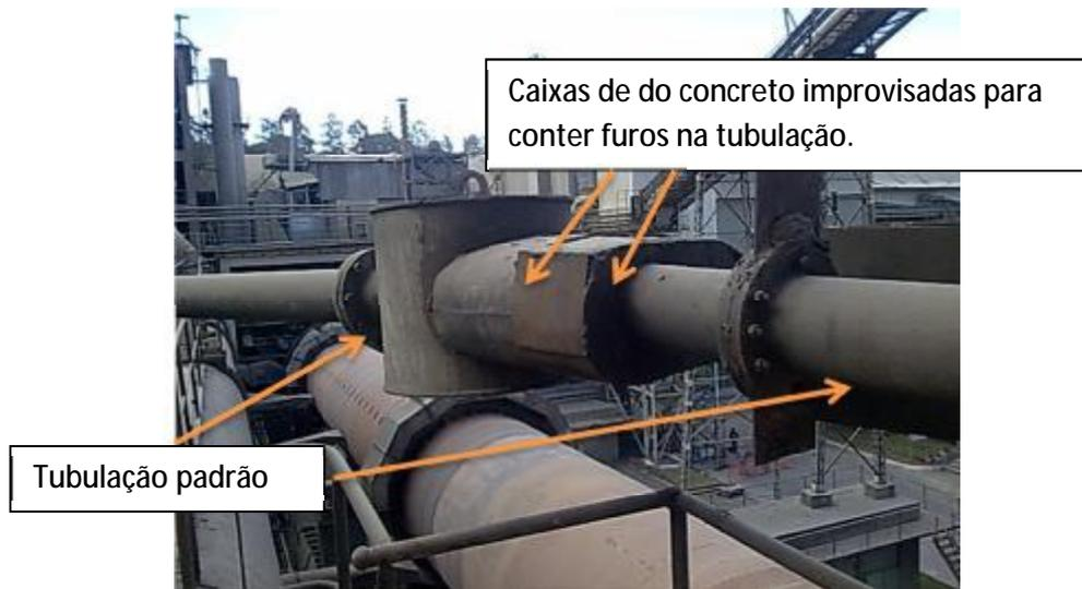
Figura 1.2: Duto de transporte de carvão em cimenteira. Originalmente uma peça Y, mas devido aos reparos emergenciais, perdeu sua geometria original.
