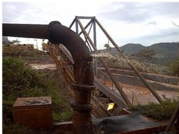
Figura 1.1: Tubulação de transporte de minério furada pela ação do desgaste
