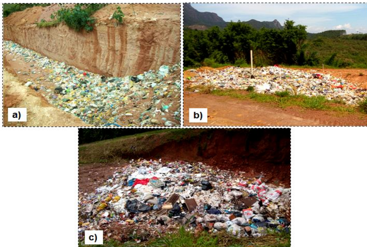
Figura 4.6- Valas de rejeitos com material espalhado sem compactação e sem recobrimento a) UTC Cristiano Ottoni; b) UTC Catas Altas e c) UTC Dom Silvério (ano de 2016)
