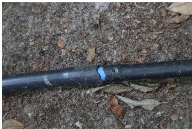
Figura 5.31 - Emenda em uma das mangueira que integram a solução de abastecimento de água da comunidade
