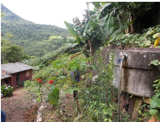
Figura 5.37 - Reservatório instalado na área externa do domicílio em cota superior ao nível da residência
