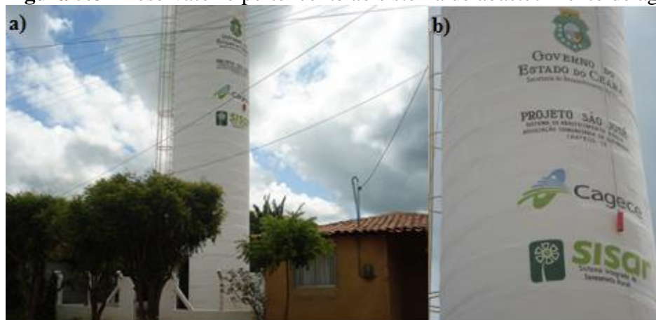
Figura 5.8 - Reservatório pertencente ao sistema de abastecimento de água
