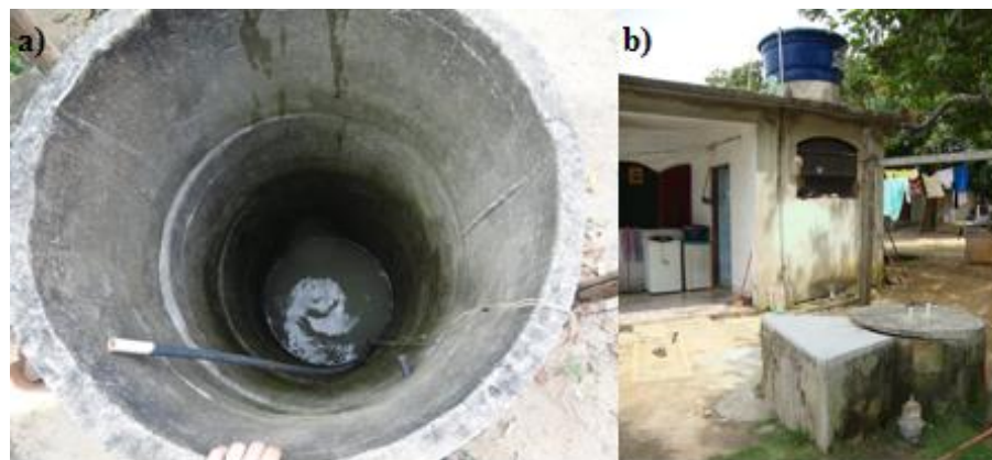
Figura 5.26 - Poços rasos escavados instalados em domicílios da comunidade
