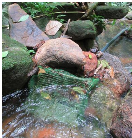
Figura 5.29 - Tela implantada em barragem construída por morador
