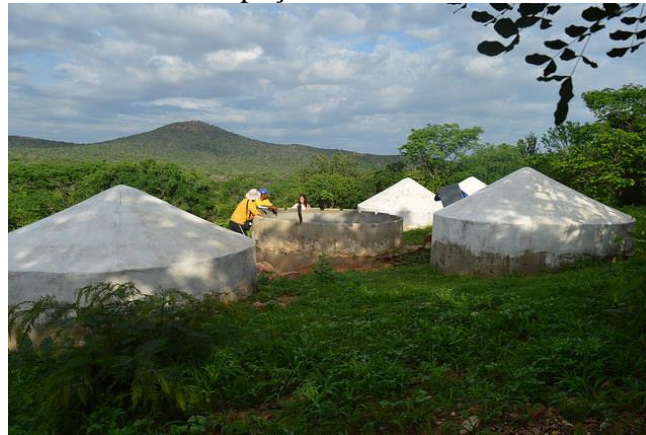
Figura 5.14 - Reservatórios utilizados para o armazenar a água captada no poço
