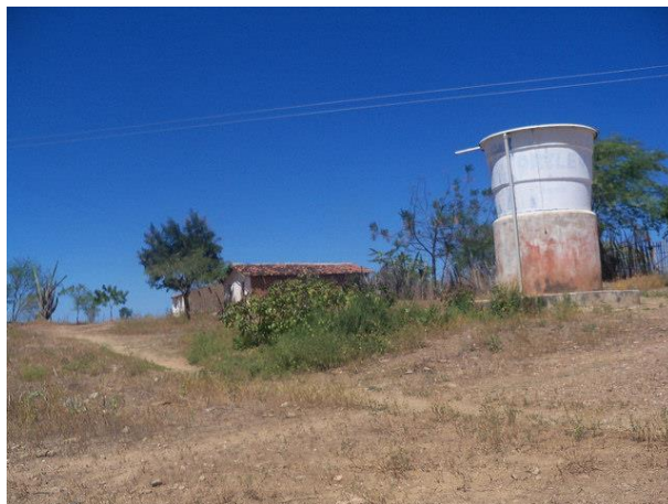
Figura 5.13 - Torneira pública instalada na comunidade
