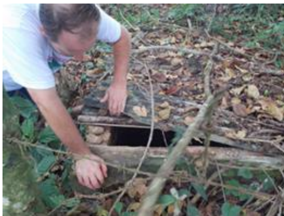
Figura 5.34 - Nascente protegida por estruturas de alvenaria e tampada por telhas de amianto
