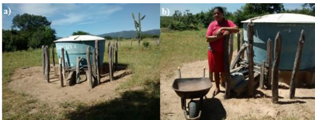
Figura 5.19 - Reservatório de água da comunidade
