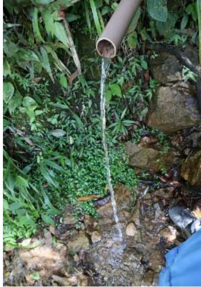
Figura 5.33 - Nascente canalizada
