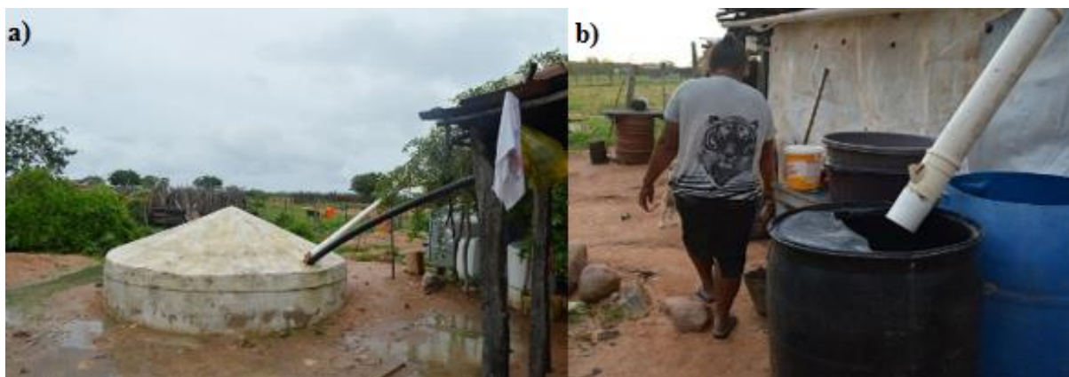
Figura 5.17 - Soluções para captação de água de chuva
