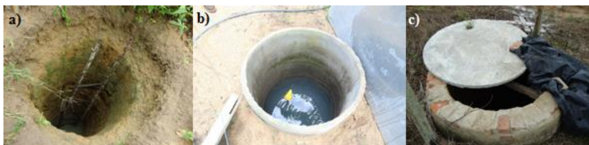
Figura 5.23 - Poços rasos escavados construídos pelos próprios moradores
