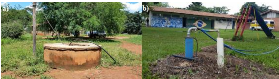
Figura 5.21 - Poços implantados na comunidade
