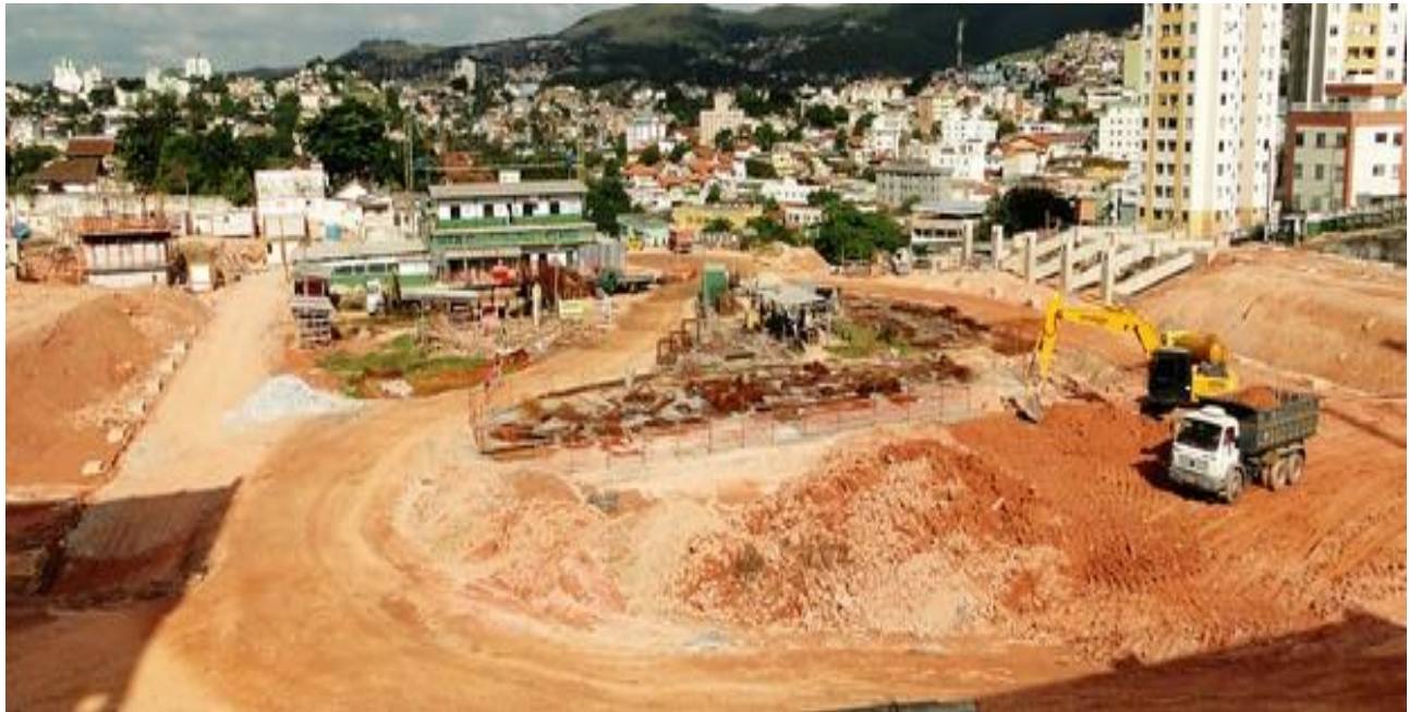
Figura 54 - Obras no Estádio Independência
