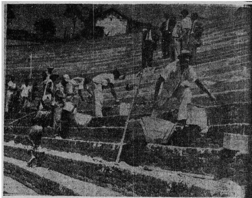
3 – Também foram iniciados os trabalhos de cimentação dos degraus, somando 30, em torno de todo o estádio. Toda a parte da imensa curva já está pronta, estando os operários em atividade nas duas retas. Também a outra curva, de concreto armado, será iniciada esta semana 178 , já que o projeto ficou pronto e o serviço de terra também teve início 179 .
