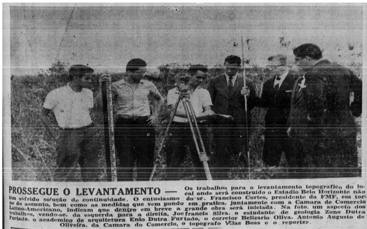
Figura 66 – Nota ilustrada tratando do levantamento topográfico.
