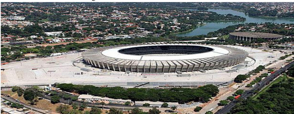
Figura 99 – Vista aérea do “Novo Mineirão”.
