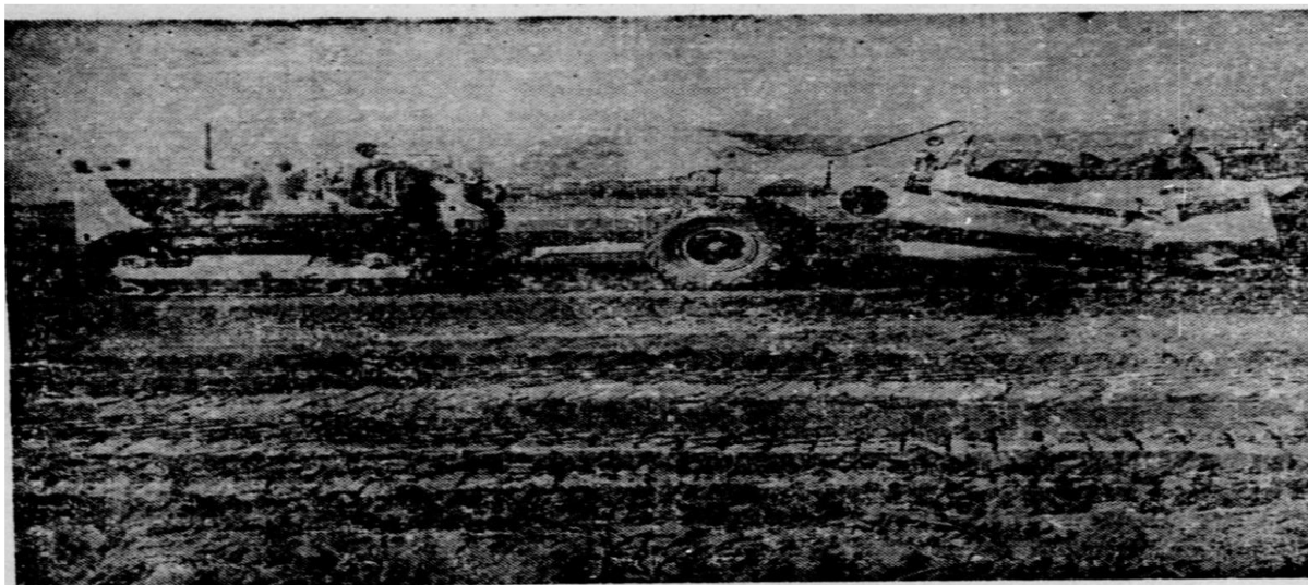
Figura 76 – Máquinas trabalhando no estádio.
