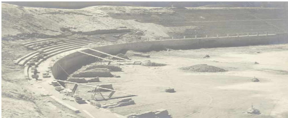
Figura 46 – Construção do Estádio Independência no final do ano de 1949.
