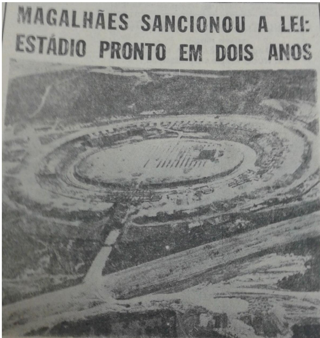
Figura 83 – Foto aérea do Estádio “Minas Gerais” em construção.
