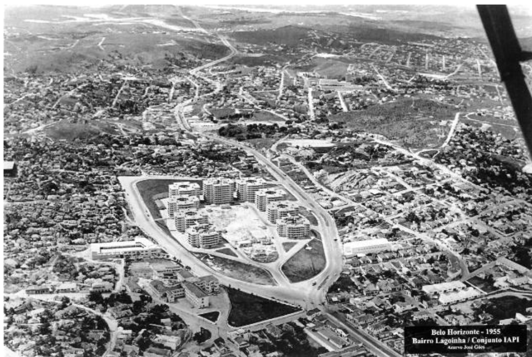
Fig. 16 - O IAPI, entre a Av. Antônio Carlos e a Pedreira Prado Lopes. José Góes, 1955. Fonte: acervo Lygia Santos.
