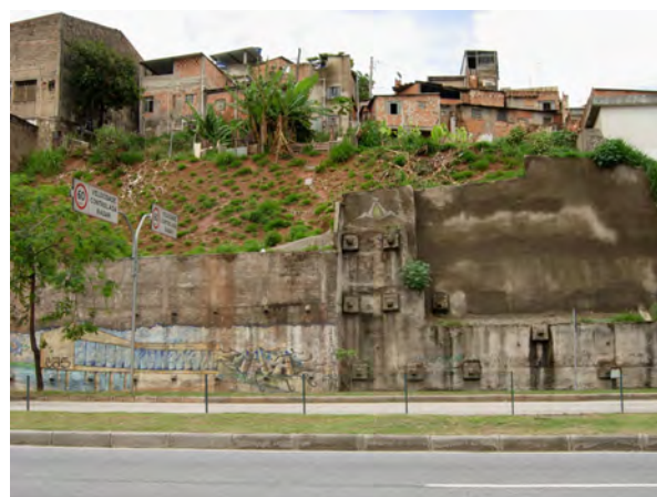
Fig. 77 - Arrimo próximo ao viaduto São Francisco.
