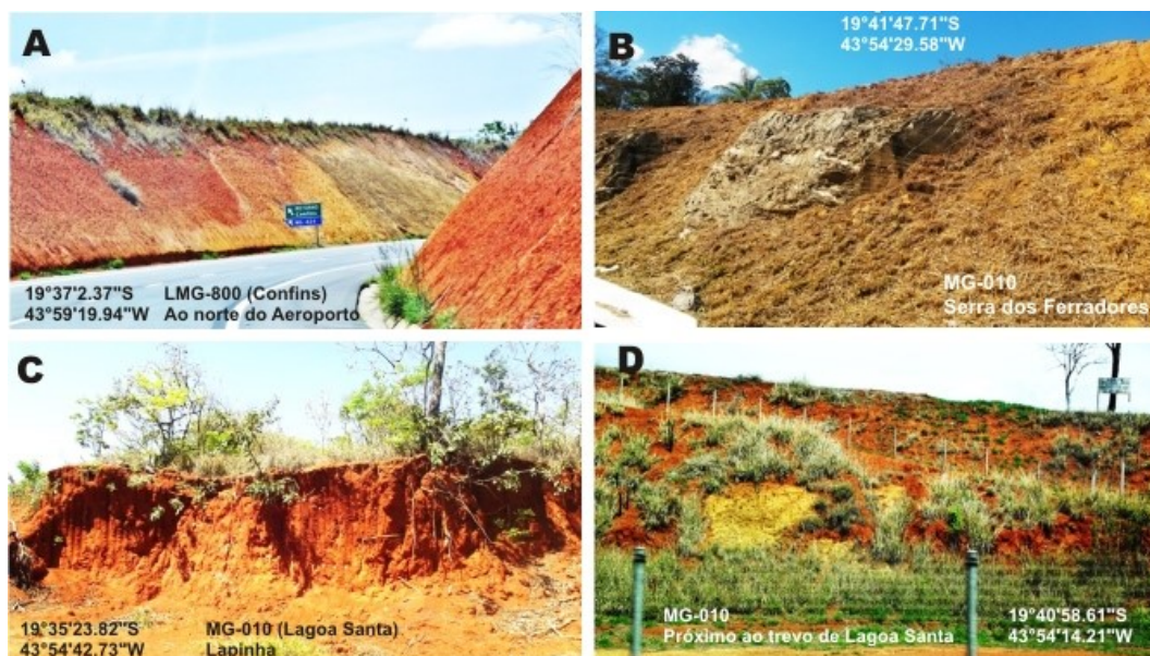
Figura 16: Aspectos das coberturas superficiais observadas em campo.
