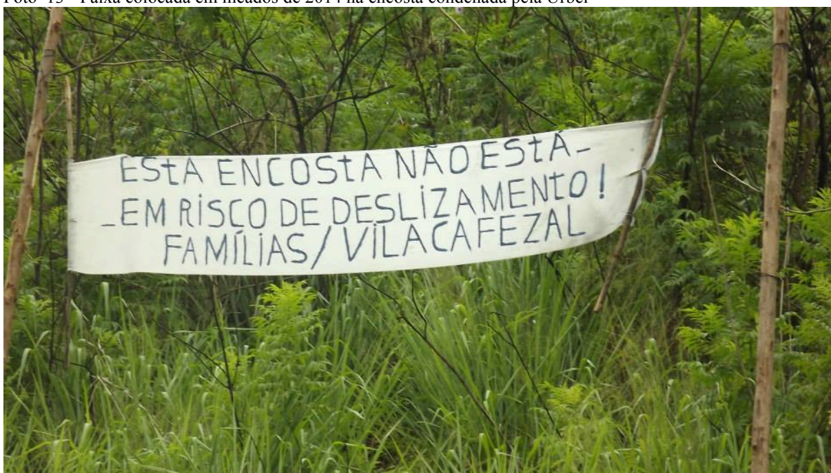
Foto 13 - Faixa colocada em meados de 2014 na encosta condenada pela Urbel
