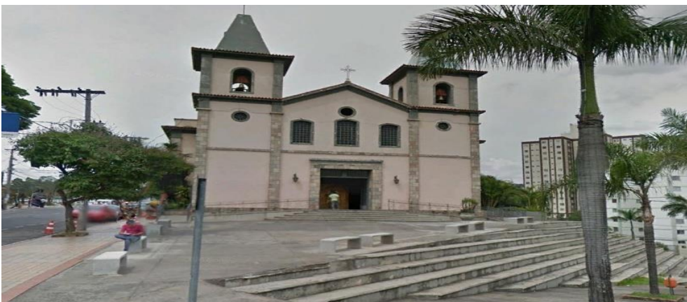
Igreja Matriz de São Gonçalo, foto atual
