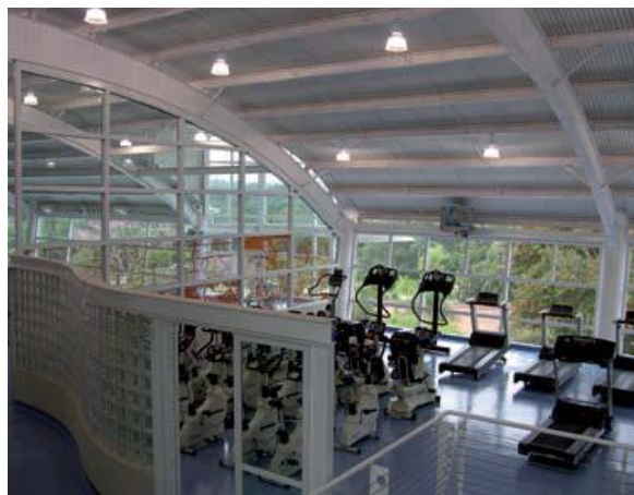
Figura 3 - Cobertura com grande caimento executada com telhas onduladas, Clube Jundiaense - SP Fonte: ABCEM, 2009, p. 19.
