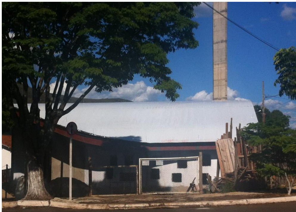
Figura 25 - Vista da cobertura da igreja Sagrada Família
