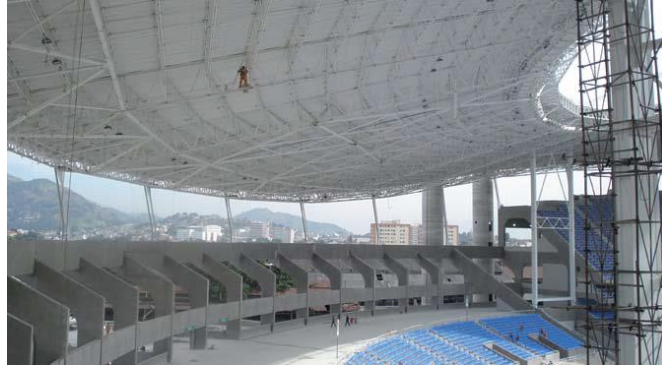
Figura 4 - Cobertura do estádio João Havelange (RJ) executada com telhas trapezoidais Fonte: SCANDAROLI, 2009, p. 16.
