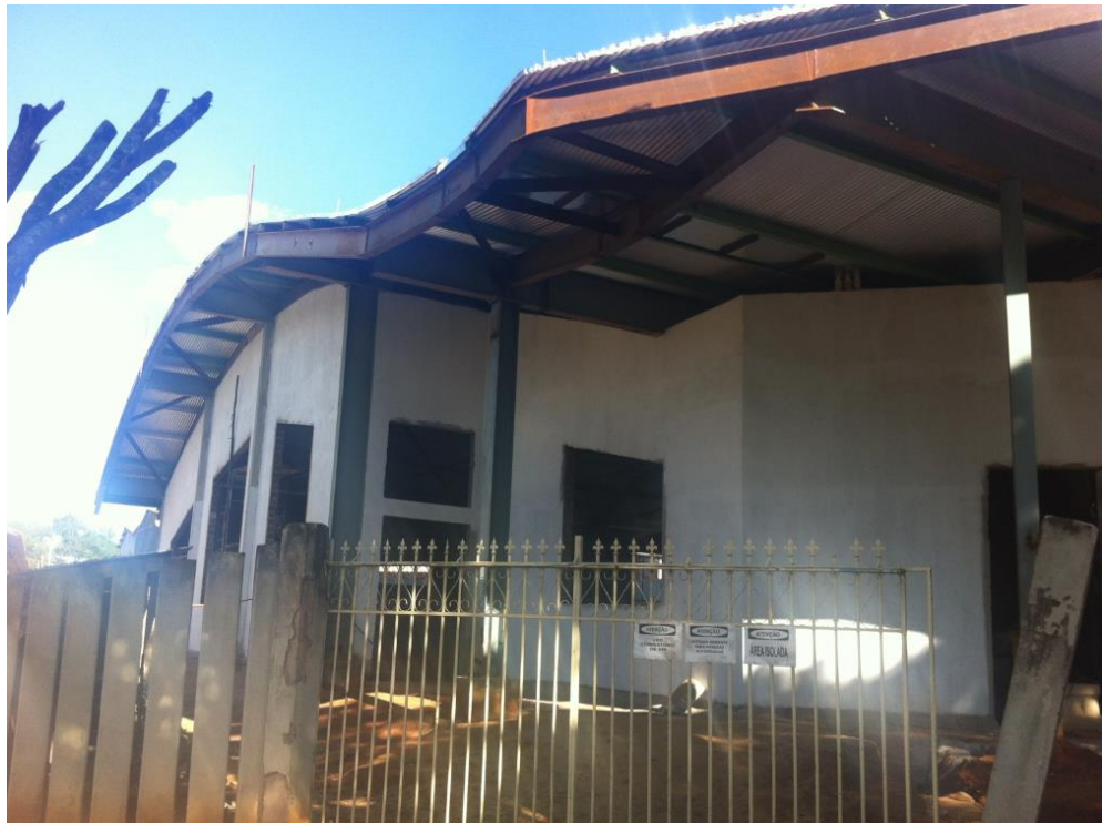
Figura 24 - Detalhe da cobertura da igreja Sagrada Família
