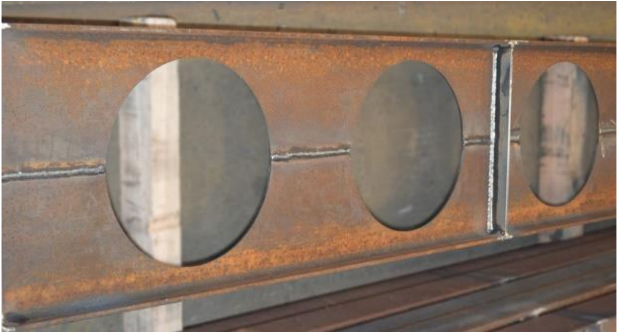
Figura 3.9 – Viga com soldas finalizadas
