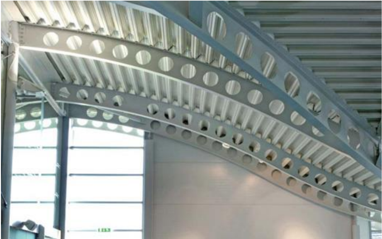
Figura 1.6 – Vigas celulares (adaptado de www.wrap.org.uk , 2016)
