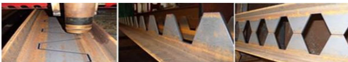
Figura 1.3 – Fabricação de vigas casteladas (fonte: BEZERRA et al. , 2013)
