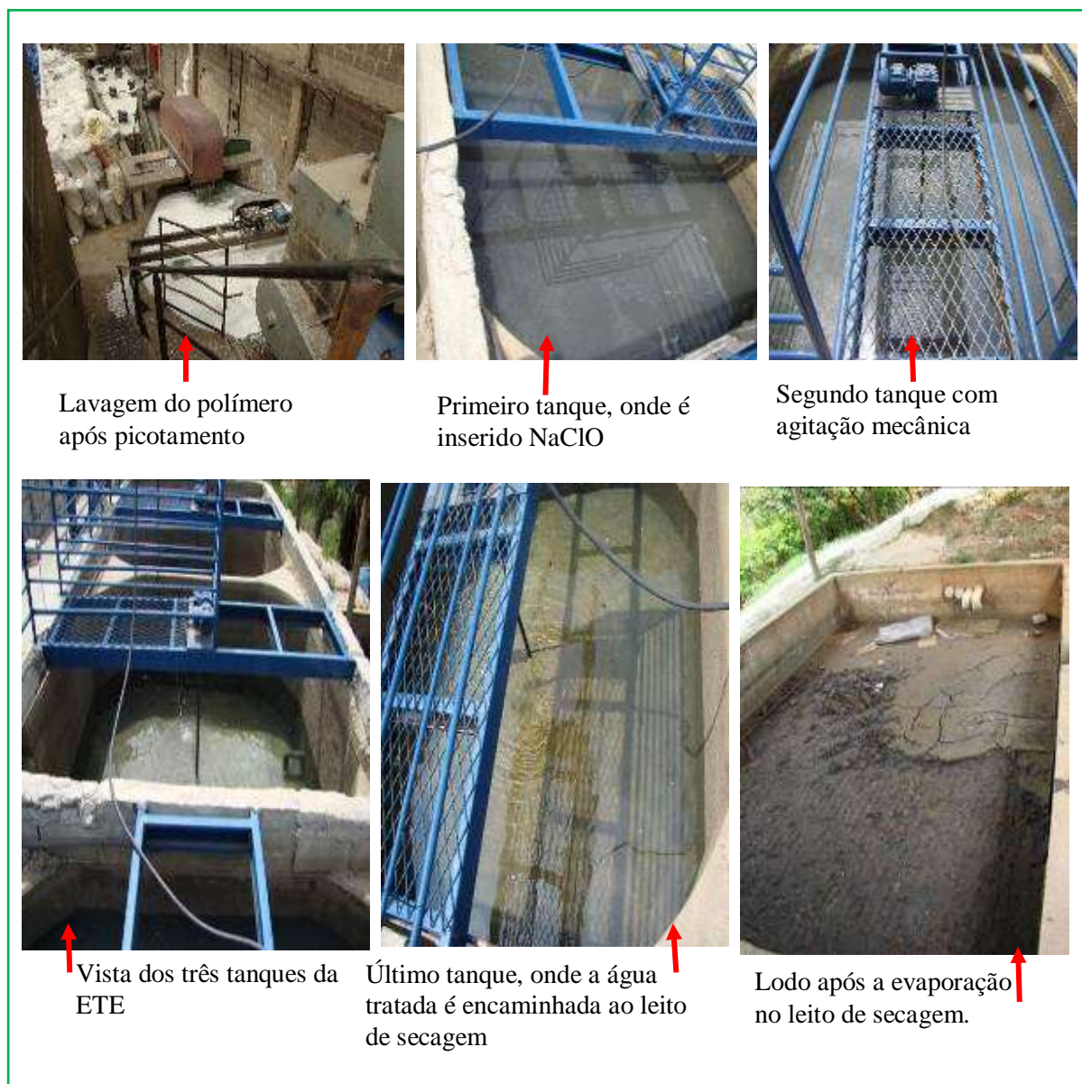
Figura 24: Etapas de tratamento da ETE da recicladora.
