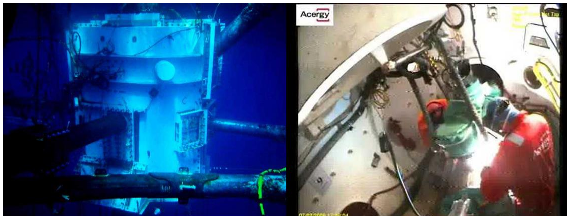
Figura 3. 1 - Soldagem Subaquática Hiperbárica [1]
