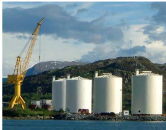
Figura 3.12: Tanque de armazenamento em LDX 2101®.
