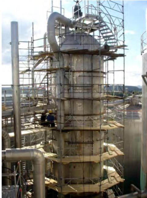
Figura 3.10: Reator de peróxido de hidrogênio em LDX 2101<sup>®</sup>, construído em 2006 (ALVAREZ-ARMAS; DEGALLAIX-MOREUIL, 2009).
