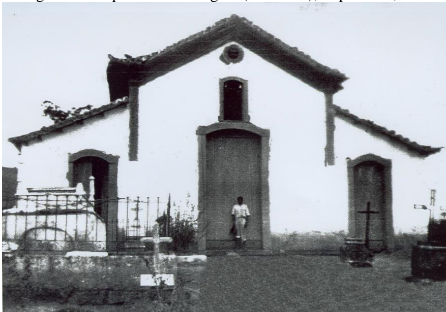
Figura 14: Capela de São Miguel (demolida), Itapecerica, MG.
