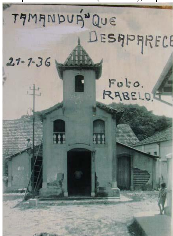
Figura 15: Capela de Santa Rita (demolida), Itapecerica, MG.
