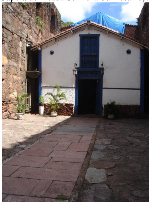
Figura 21: Capela de Nossa Senhora do Rosário, Sabará, MG.
