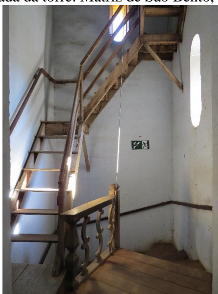
Figura 113: Escada da torre. Matriz de São Bento, Itapecerica, MG.
