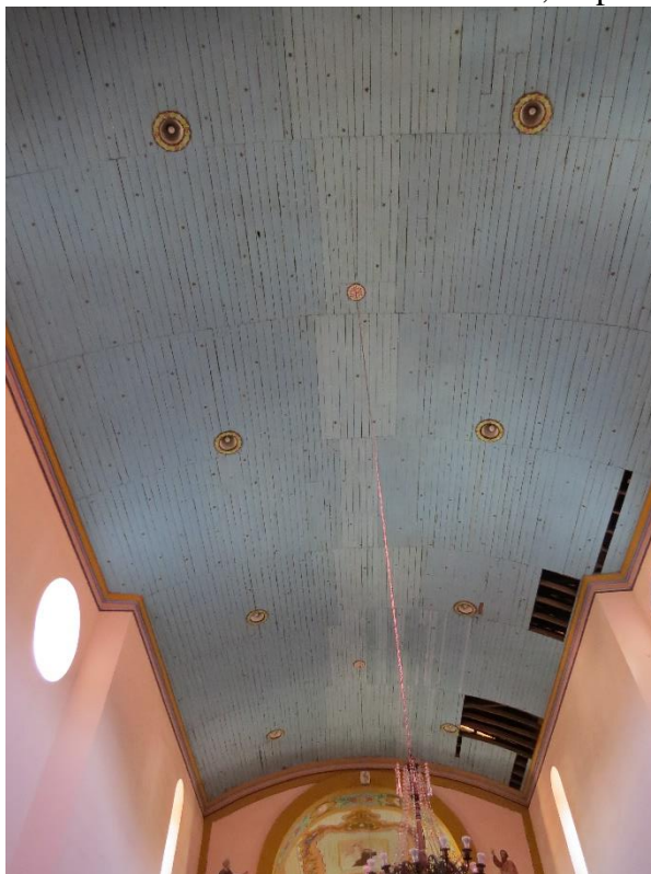
Figura 109: Forro da nave. Matriz de São Bento, Itapecerica, MG.
