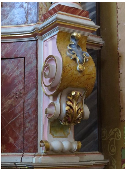
Figura 69: Detalhe da mísula. Retábulo de altar-mor. Matriz de São Bento, Itapeçerica, MG.
