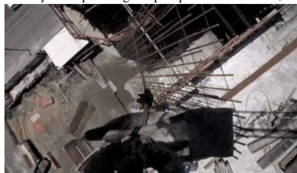
FIGURA 6.8 – d) Plano vertiginoso de estrutura metálica içada ao topo de prédio em construção.
