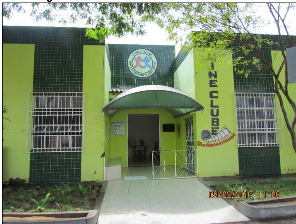
Figura 13 - Foto da fachada do Centro de Cultura
