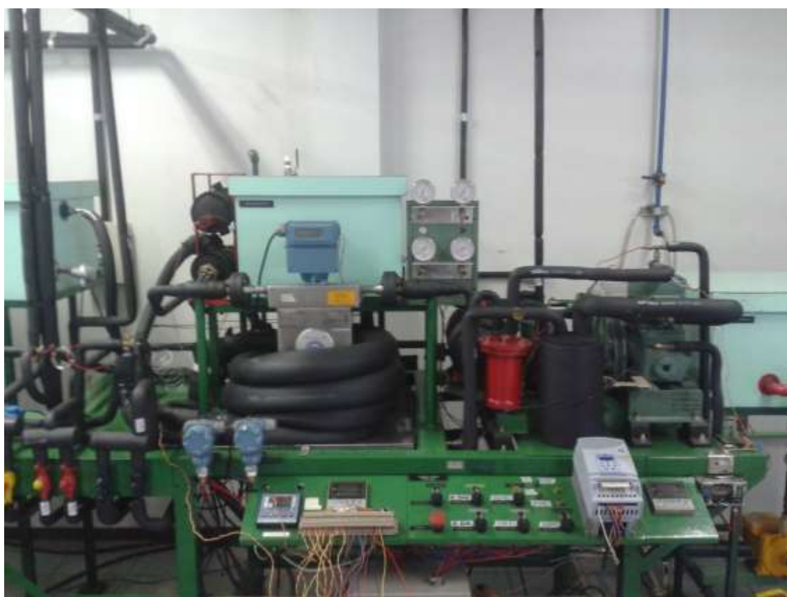
FIG. 4.1– Bancada de teste máquina frigorífica do Grupo de Refrigeração do Departamento de Engenharia Mecânica da UFMG FONTE – Elaborada pelo autor
