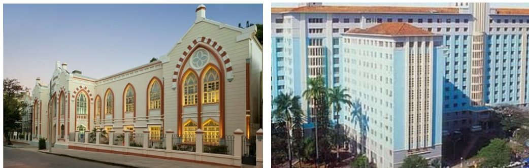
Figura 5 - Antigo prédio da Maternidade Hilda Brandão fundada em 1916 (à esquerda). Prédio atual da Santa Casa Belo Horizonte onde funciona a Maternidade Hilda Brandão desde 2006 (à direita). Belo Horizonte – M.G.
