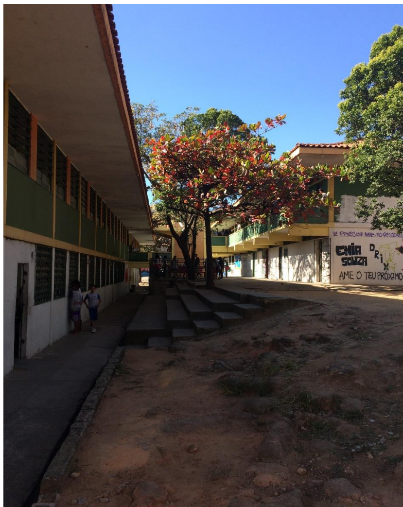
Figura 2 – Os dois prédios da escola vistos pelo lado oposto à entrada
