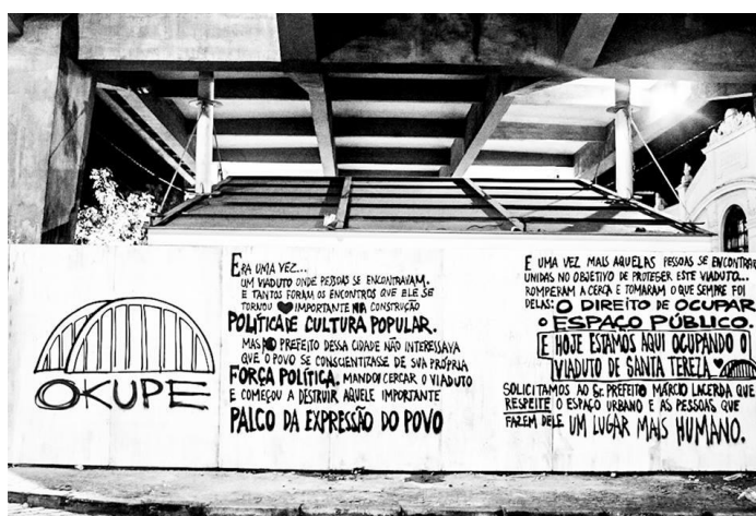
Pintura realizada na madeirite que circundava o Viaduto Santa Tereza quando do início da obra de reforma em 2014. Está escrito:
