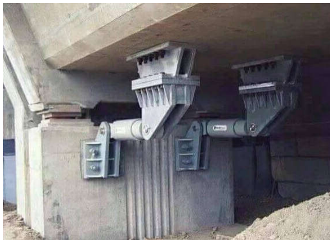
Figura 1 – Amortecedores utilizados em uma ponte (extraído de https://www.facebook.com/SiteAEngenharia/photos/pcb.1014279722002872/1014278818669629/?type=3&theater ).
