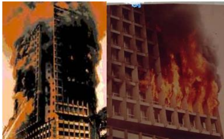
Figura 2.2: Incêndio no Edifício Joelma (NEGRISOLO, 2011)
