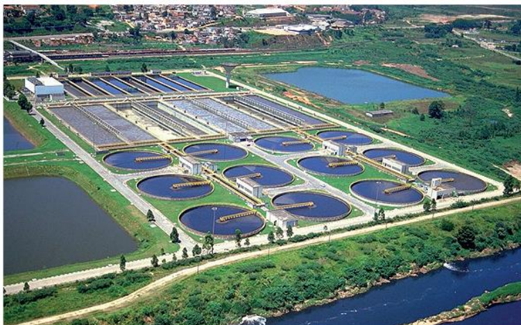
Estação de Tratamento de Esgoto, em Barueri (SP)
