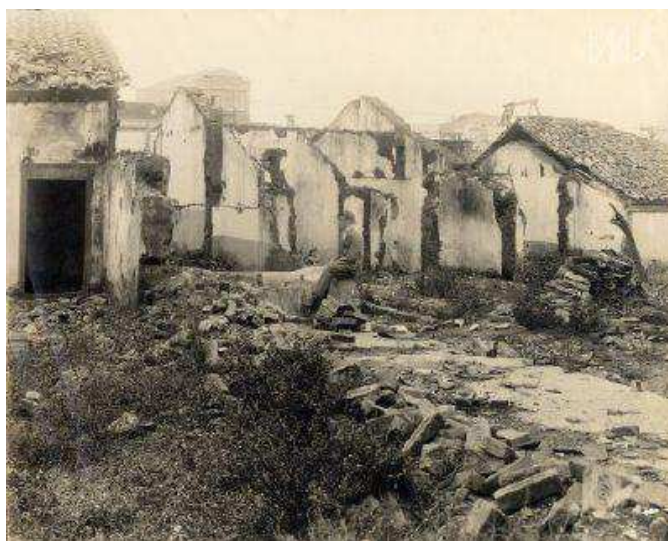
Ft.3J - Vincenzo Pastore, Casario em demolição na Rua da Esperança , 1912
