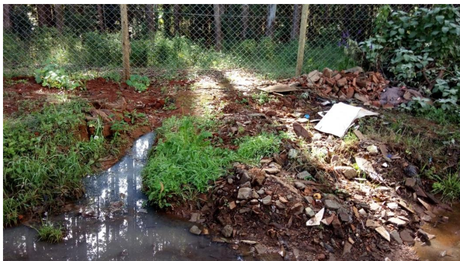
Figura 5.10 - Rua Monte Vista, bairro Jardim Canadá
