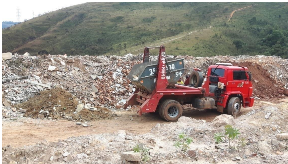
Figura 5.16 - Operação no aterro de inertes no Mingu
