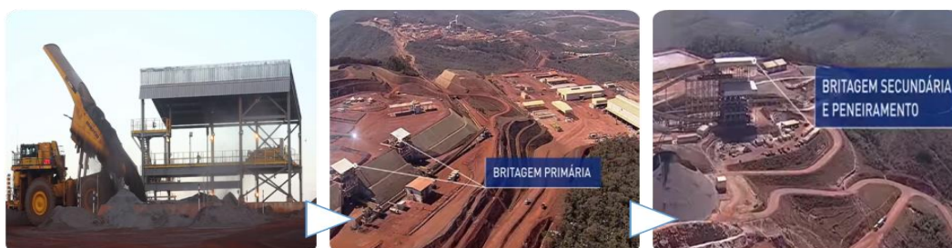
Figura 5 - Processo de britagem primária e secundária
