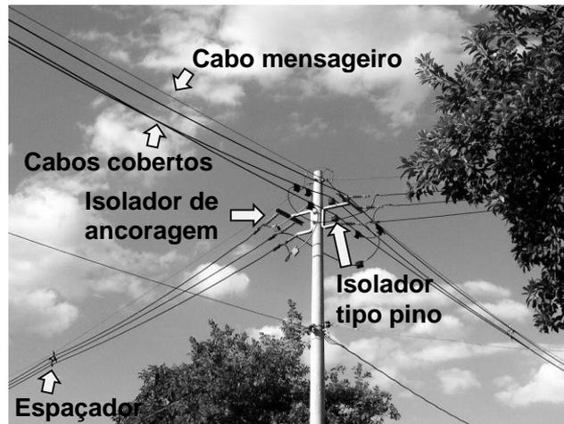
Figura 3.2 – Rede de distribuição compacta. Adaptada de (SOUZA; GOMES; et al., 2017).
