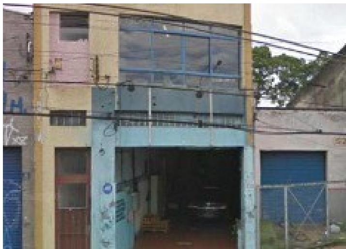
Figura 3: Prédio onde se instalava a oficina que produzia para a Zara (Fotos: SRTE/SP, FF e BP)
