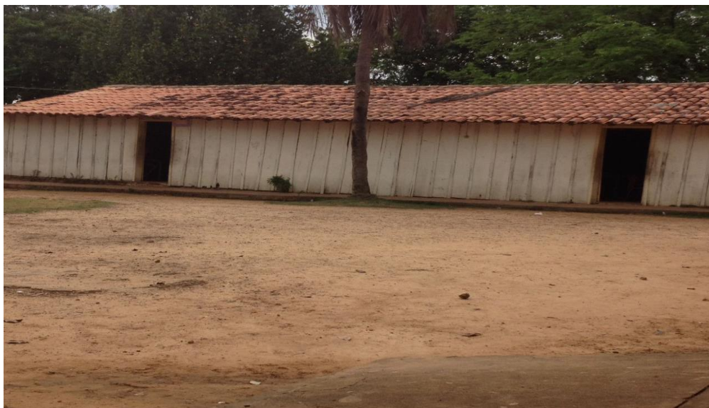
Figura 3 - Espaço anexo de uma escola municipal da área rural do município de Araguatins
