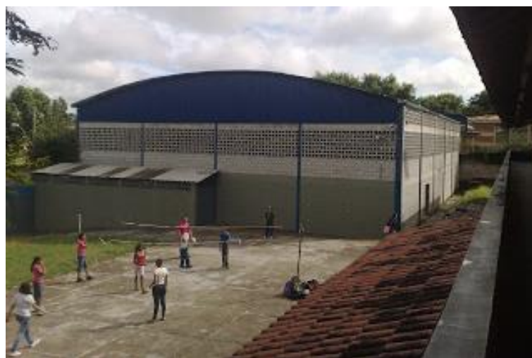
Figura 3- Quadra poliesportiva coberta
