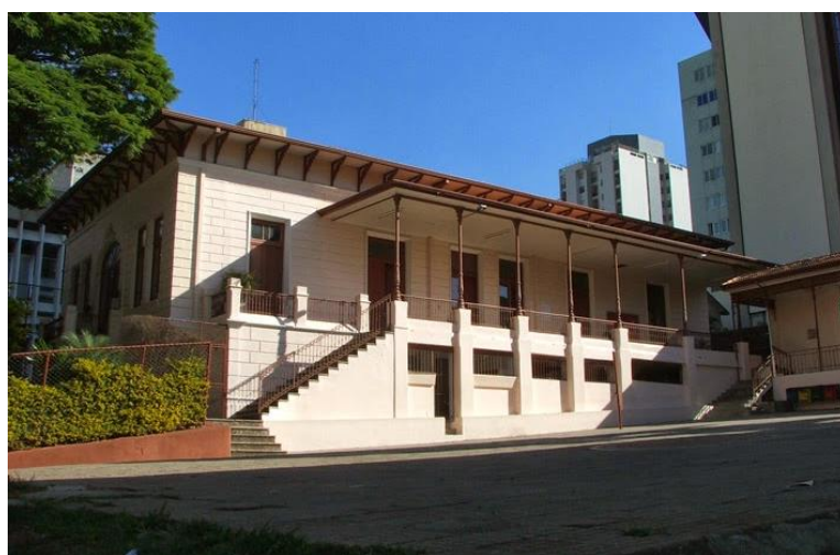
Figura 8 - Foto da entrada principal, tirada do lado de fora da Escola 5
