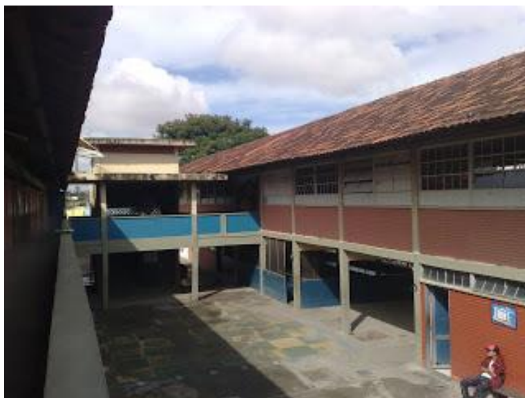
Figura 2 - Foto do pátio no interior da Escola 1
