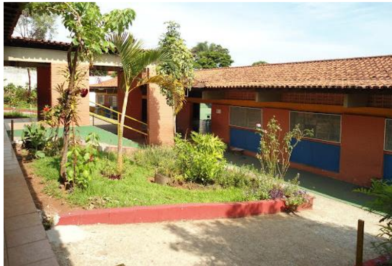
Figura 5 - Pequeno espaço entre os blocos de salas de aula
