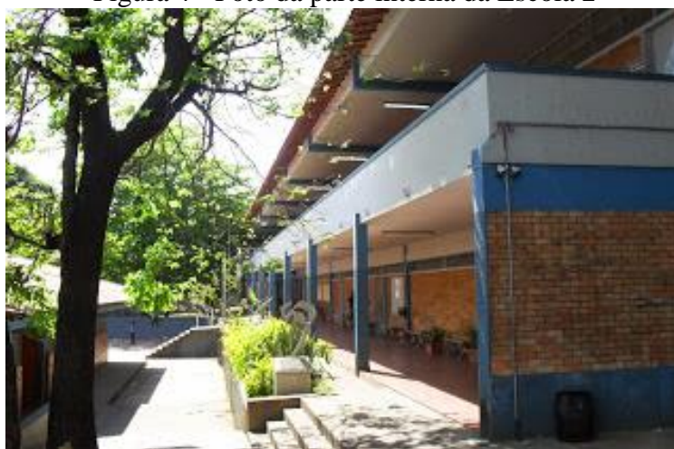
Figura 4 - Foto da parte interna da Escola 2
