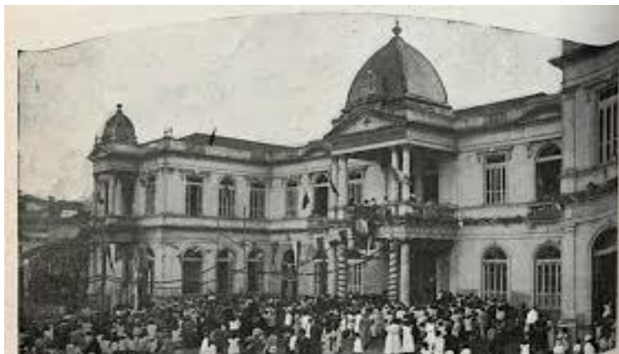
Figura 2: Instituto de Proteção à Infância no Rio de Janeiro. Fonte: EDUCERE 10 .
