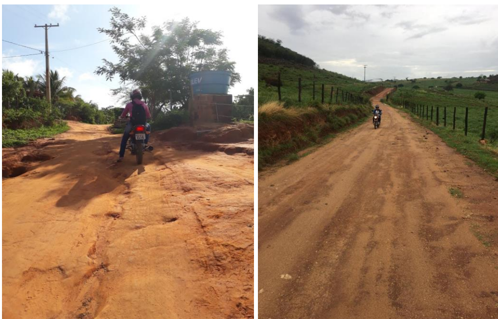
Figura 5 - Condições de deslocamento nas estradas de chão
