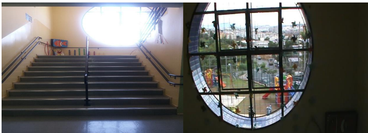
Figuras 19 e 20- Escada de acesso ao 2º pavimento e Janela da EMEI. Fonte: Dados da pesquisa, 2017.
