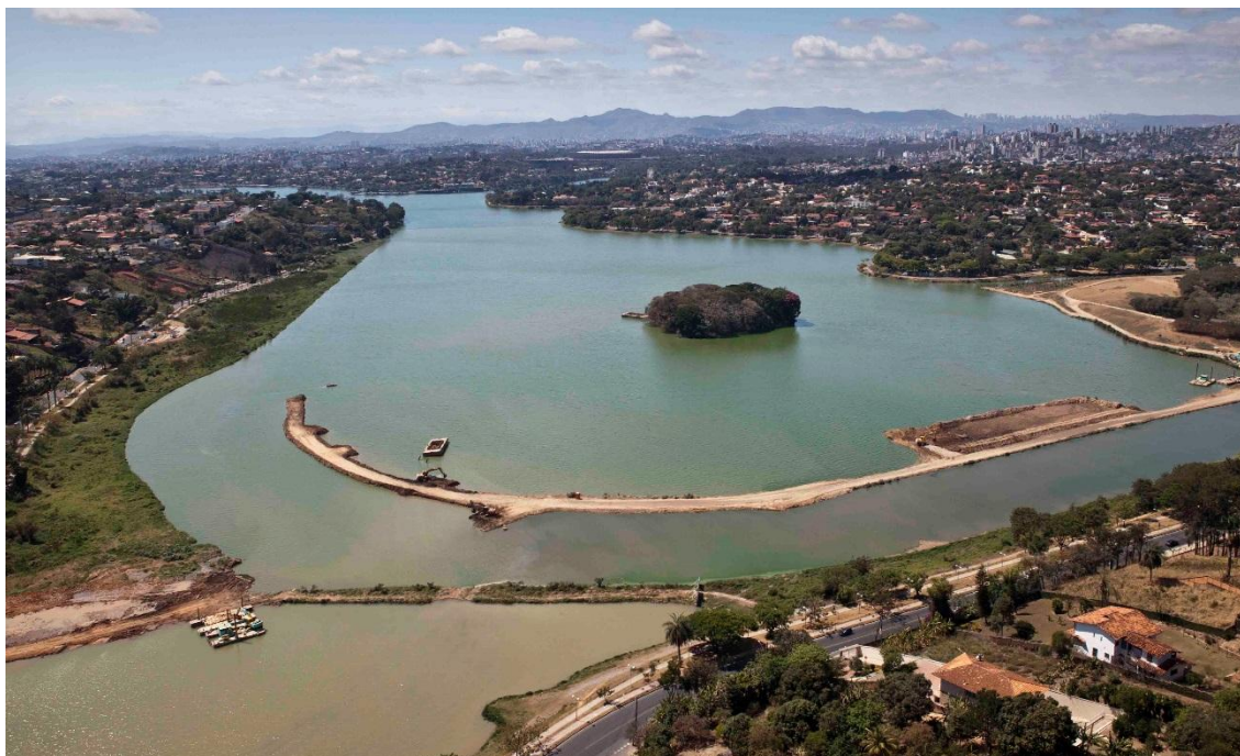
Figura 11: Fase avançada dos serviços de desassoreamento da Lagoa da Pampulha em outubro de 2014
