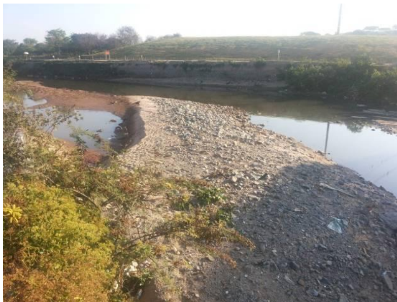
Figura 15: Sinais de assoreamento no Córrego Sarandi no trecho a jusante da sua confluência com o Córrego Ressaca
