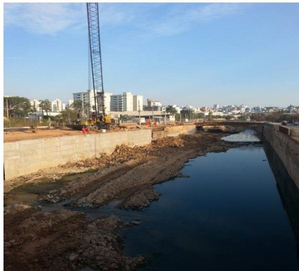
Figura 32: Obras de tratamento de fundo de vale executadas no canal do Córrego Ressaca
