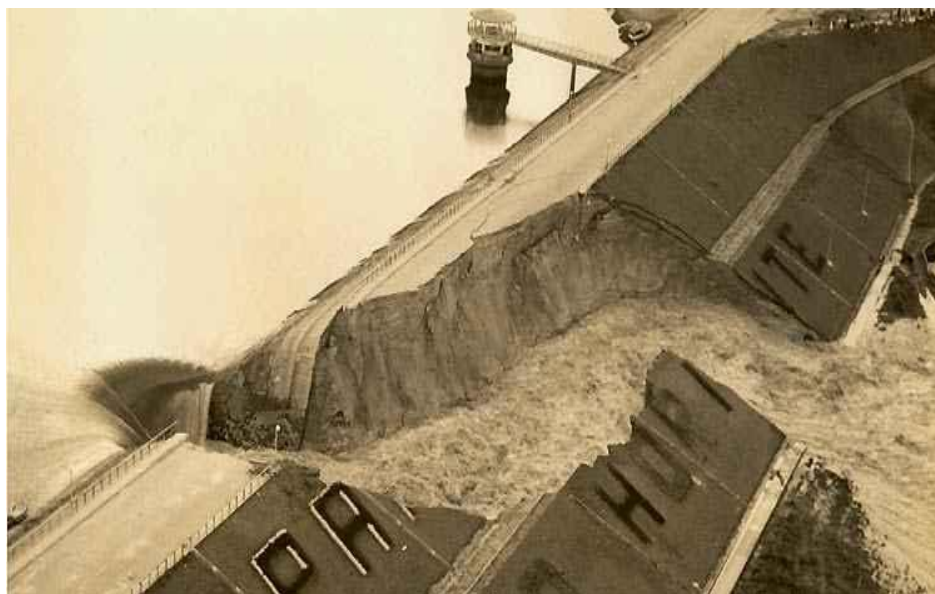
Figura 7: Ruptura da barragem da Pampulha em abril de 1954.
