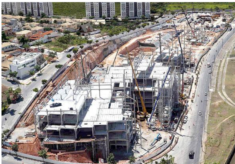
Figura 31: Execução das obras do Shopping Contagem
