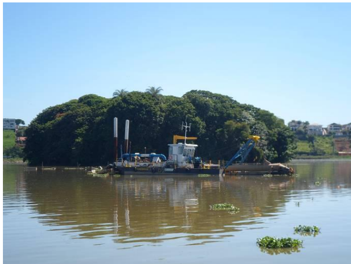
Figura 35: Dragagem sobre balsa executando dragagem nas imediações da Ilha dos Amores
