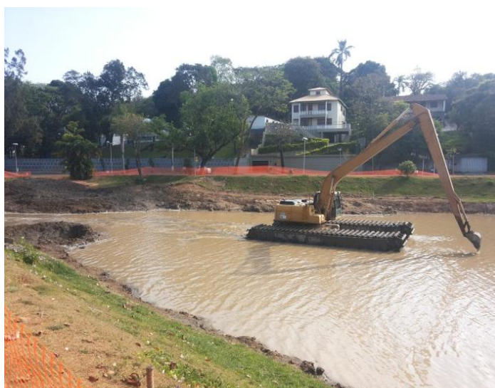
Figura 34: Escavadeira anfíbia em operação na Enseada das Garças.
