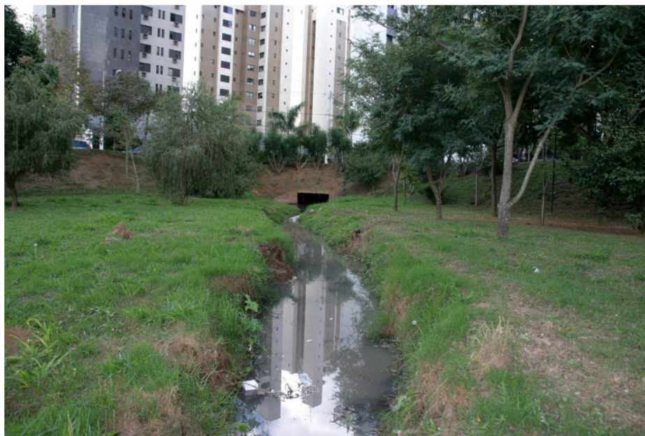
Figura 04: Bacia de detenção da Lagoa Seca no bairro Belvedere/Belo Horizonte (2009)
