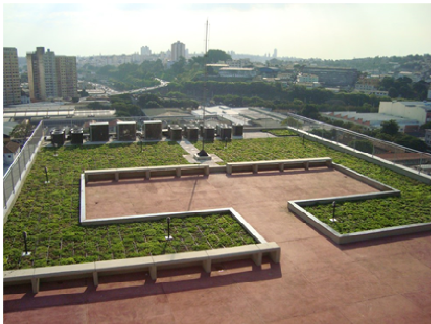
Figura 06: Implantação de telhado verde no Banco do Brasil – Belo Horizonte
