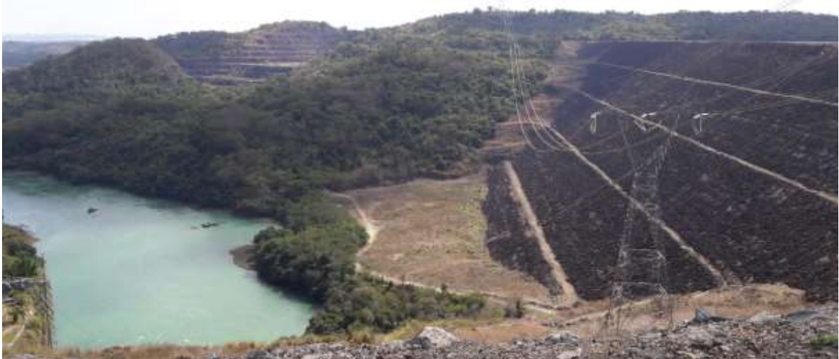
Figura 3 - Grande Central Hidrelétrica Emborcação
