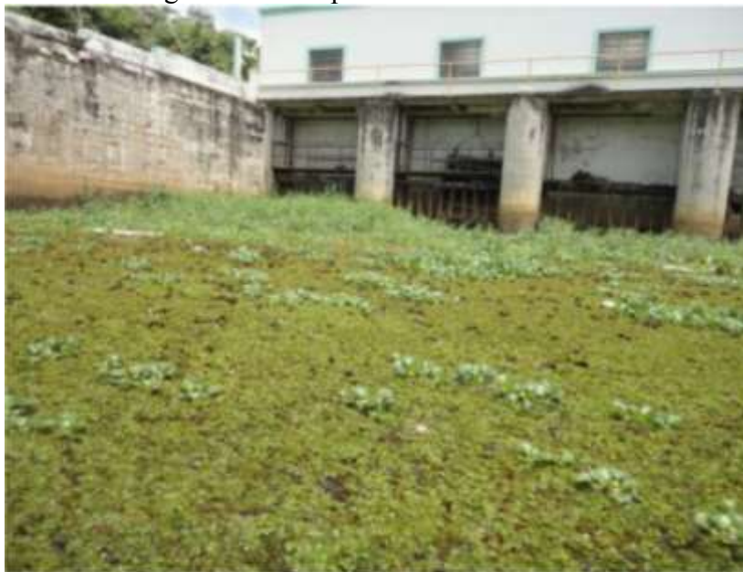
Figura 7 - Tomada d'água recoberto pelas macrófitas na PCH Gafanhoto, rio Pará
