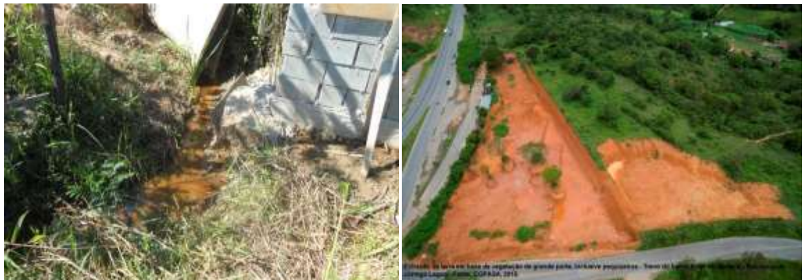
FIGURAS 13 e 14 – Ocupações irregulares em APPs e supressão de vegetação de Vargem das Flores (Bairros Nascentes Imperiais e Solar do Madeira)
