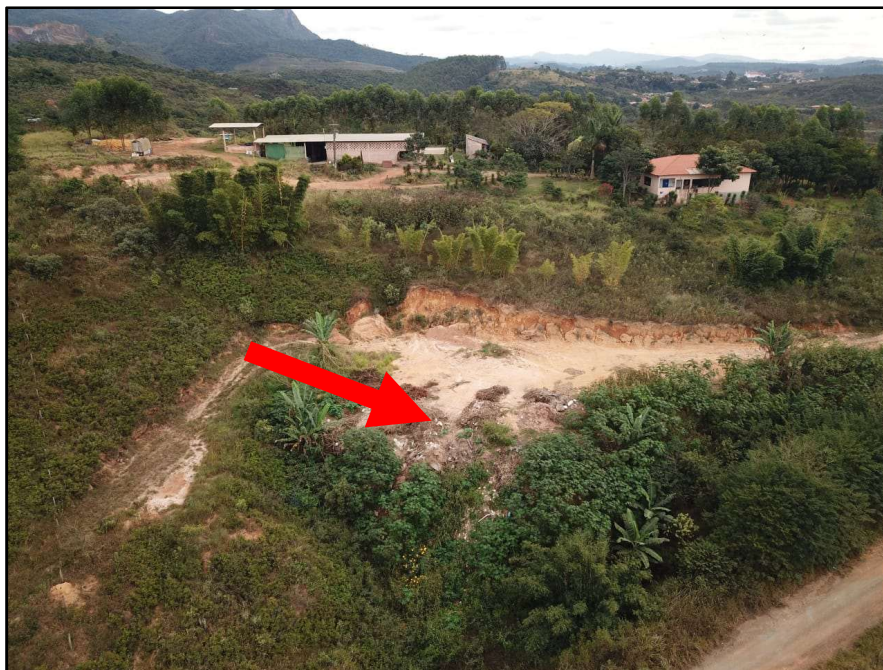
Figura 14 - Bota fora de RCC na área do aterro controlado.
