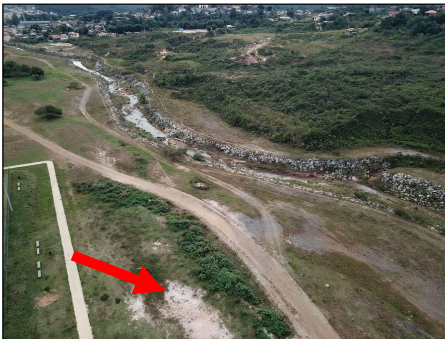
Figura 13 - Bota fora de RCC as margens do Rio Maquiné.
