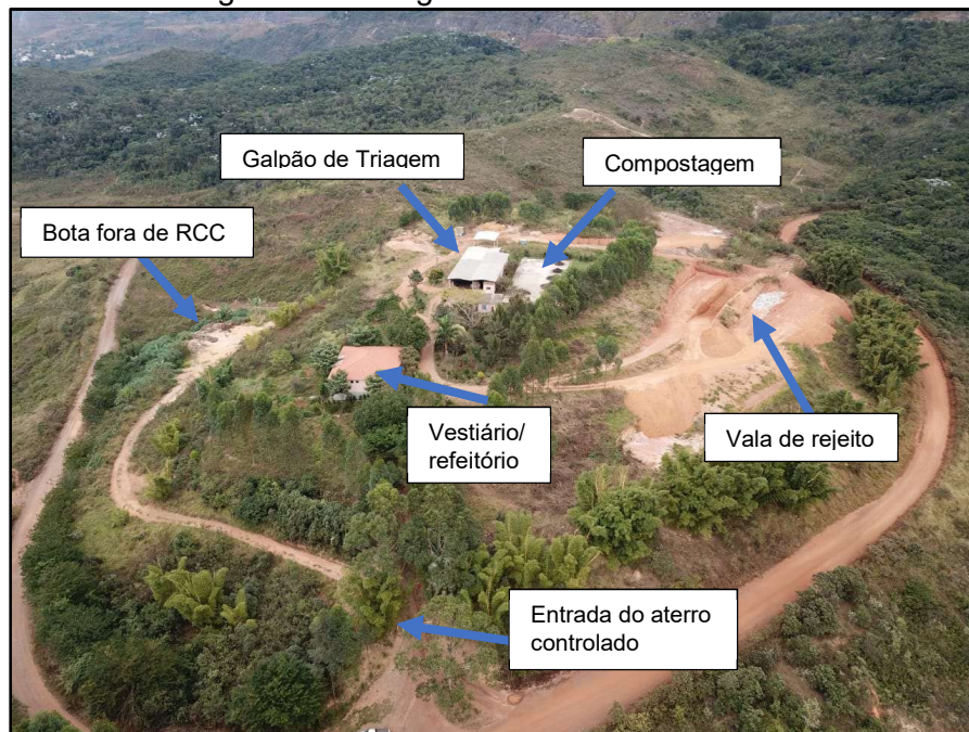
Figura 6 - Vista geral do Aterro Controlado.
