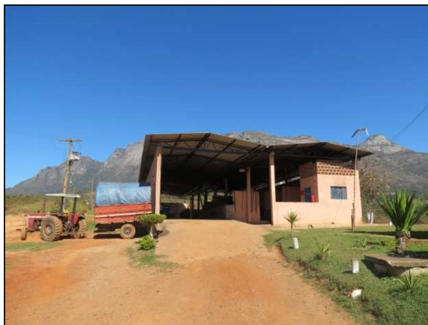
Figura 7 - Vista Geral da Unidade de Triagem e Compostagem (UTC).
