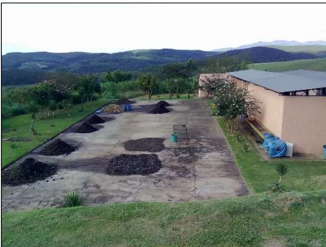
Figura 10 - Vista Geral do Pátio de Compostagem.
