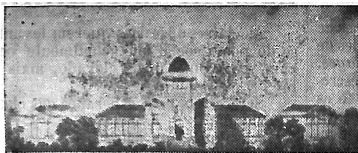
Figura 10 – Edifício construído para escola maternal
