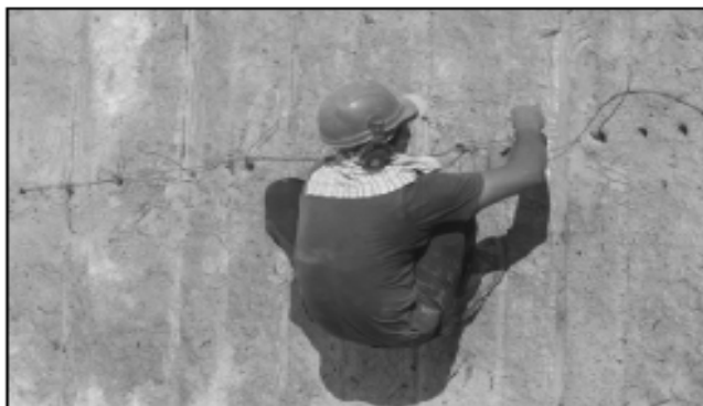
Figura 3.18: Colocação de explosivo para desmembramento da prancha.
