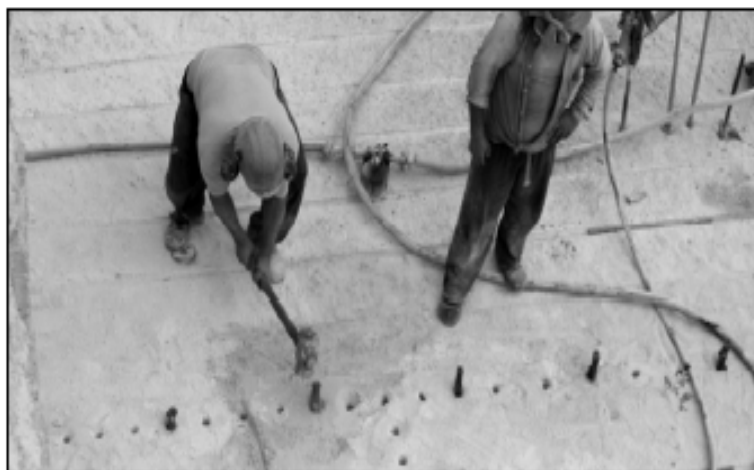
Figura 3.19: Execução da divisão mecânica por intermédio de cunhas. (REGADAS, 2006)
