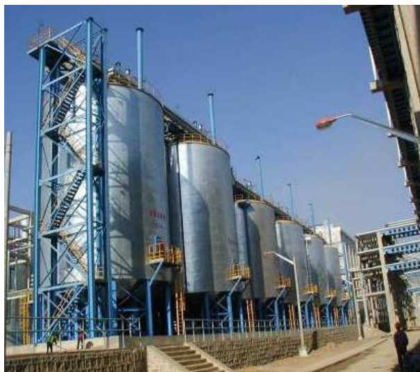
Figura 3.5: Espessadores de pasta Eimco Deep Cone. (Tão et al, 2008)
