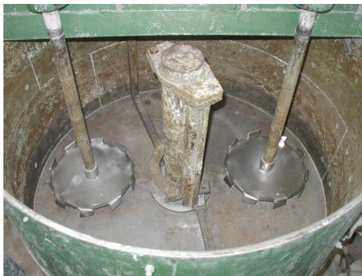
Figura 3.54 – Vista interna do misturador com hélices dispersoras.
