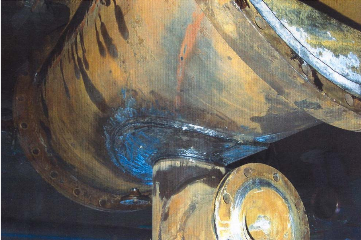
Figura 40: Colarinho de reforço ao carretel
