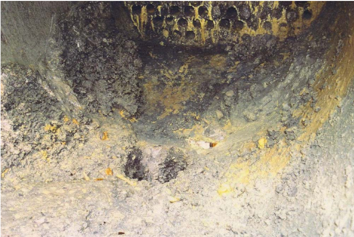
Figura 35: Depósito de consistência pastosa, não aderente, na seção inferior do carretel, sobre a seção inferior do espelho
