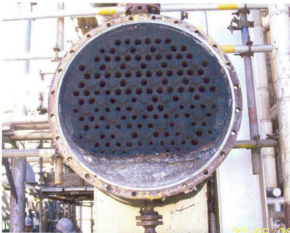
Figura 28: Depósito escuro e aderente no feixe do Permutador 114-E-02
