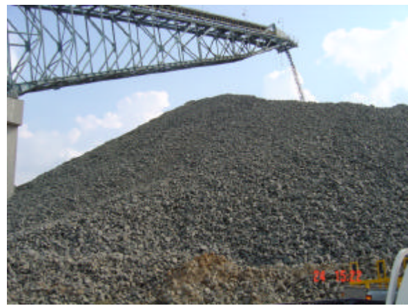
Figura 5.2 - Descarga do material britado na pilha pulmão.
