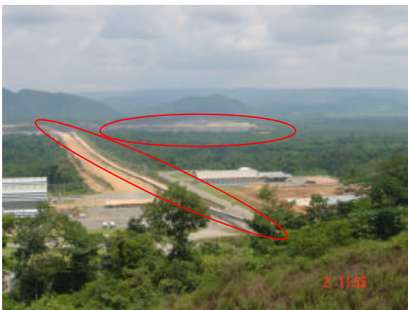
Figura 5.1 - Detalhe da mina de Sequeirinho ao fundo e correia transportadora do material britado.
